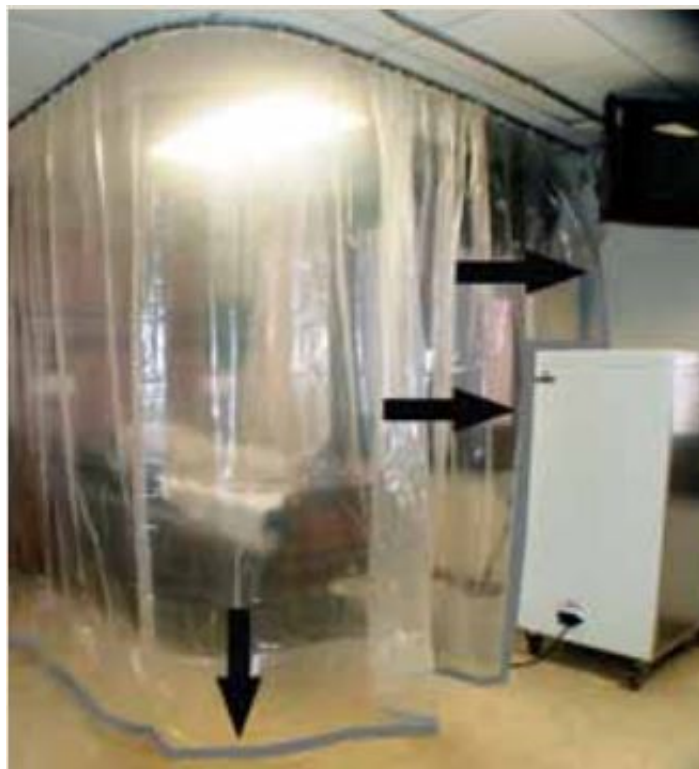
Figura 4 - Isolamento temporário por pressão negativa com delimitação por cortinas plásticas. Excerto da ref (3).
